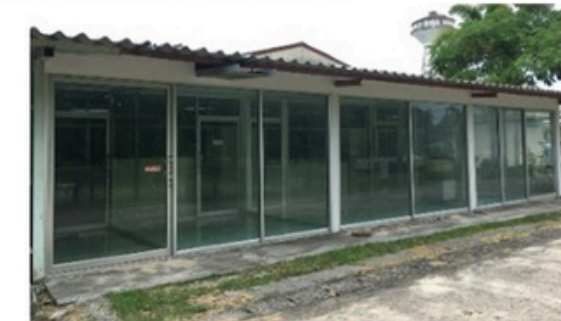
SW. สิงหนคร จังหวัดสงขลา (กำลังสร้างอาคารผลิตใหม่)
